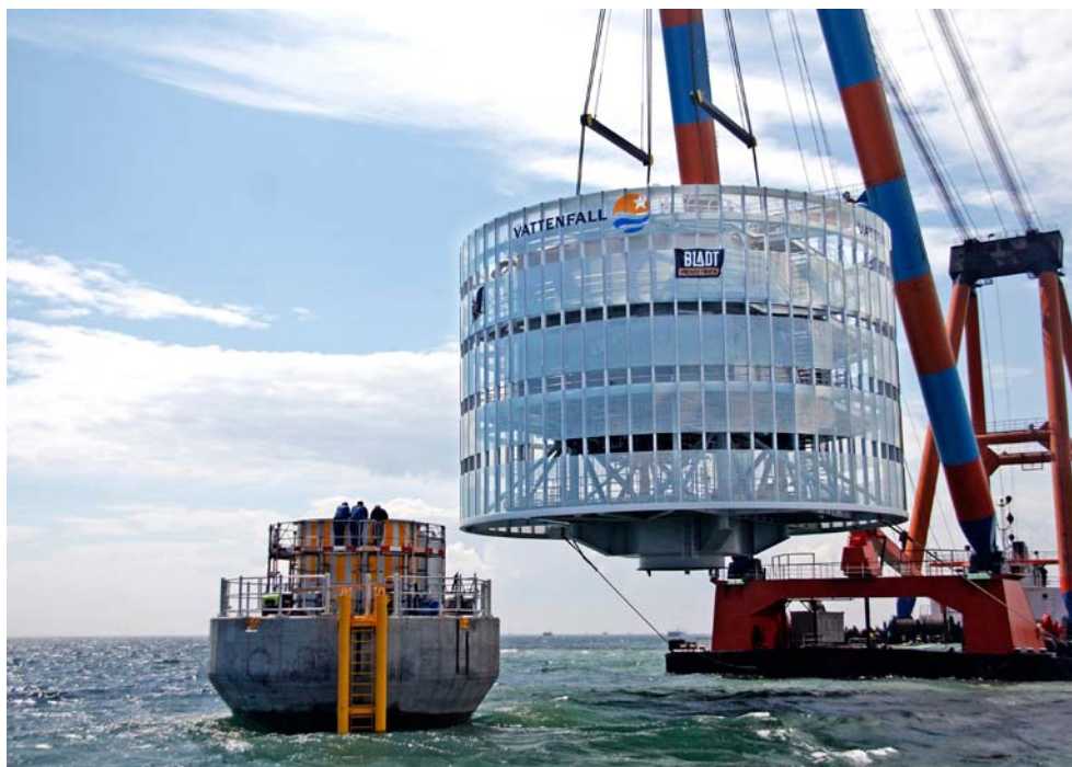
Bild 5. Installation av transformatorstation vid Lillgrund (foto: Hans Blomberg/Vattenfall).
