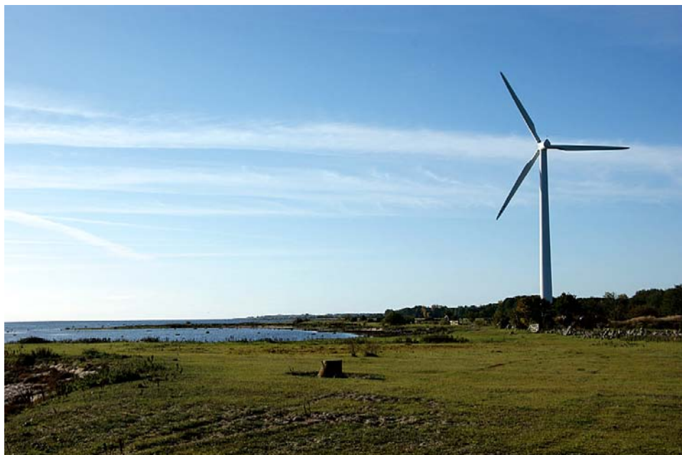
Fig. A1. Exempel på vindkraftverk på en plats med förhöjd kollisionrisk för fåglar och fladdermöss, i det här fallet vid kusten på norra Öland. Vid fotograferingstillfället hittades kadaver av en knölsvan och en stor fladdermus. Foto Ingemar Ahlén.
