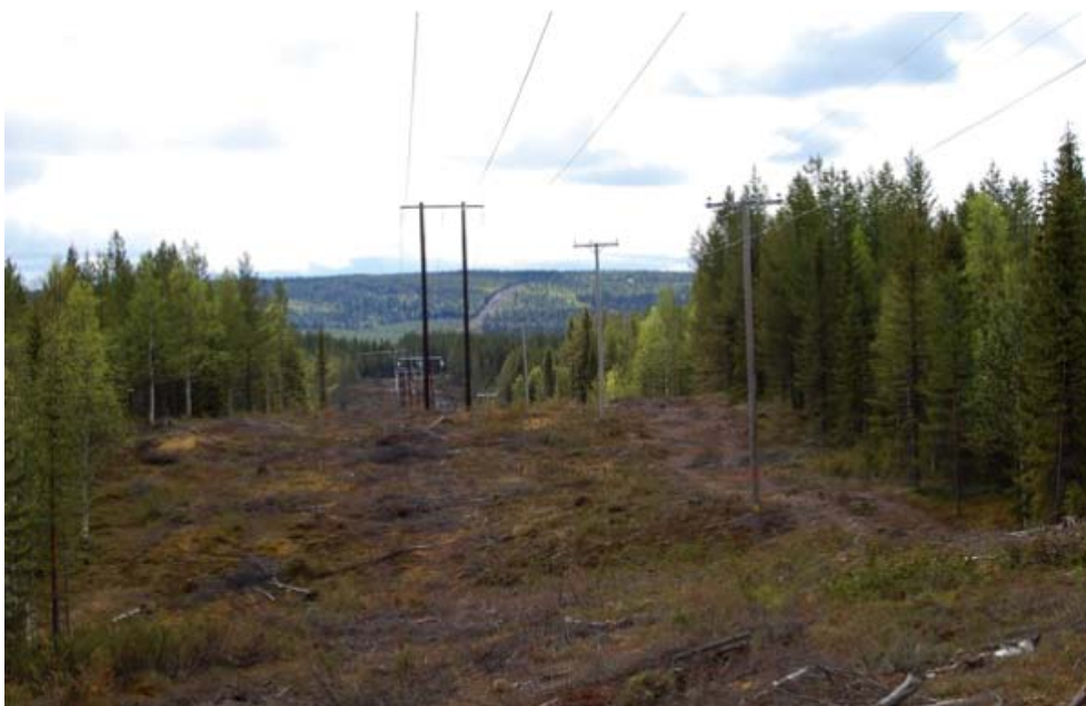
Ny kraftledning i anslutning till Jokkmokklidens vindkraftpark, Malå kommun. I bakgrunden syns även en ny kraftledningsgata till Storlidens vindkraftpark. Foto Anna Skarin.
